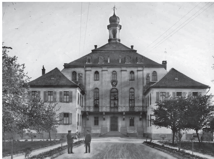
Ansicht des Hauptgebäudes von Norden, 1913 [Generallandesarchiv Karlsruhe, Abt. 498-1, Nr. 6169]
