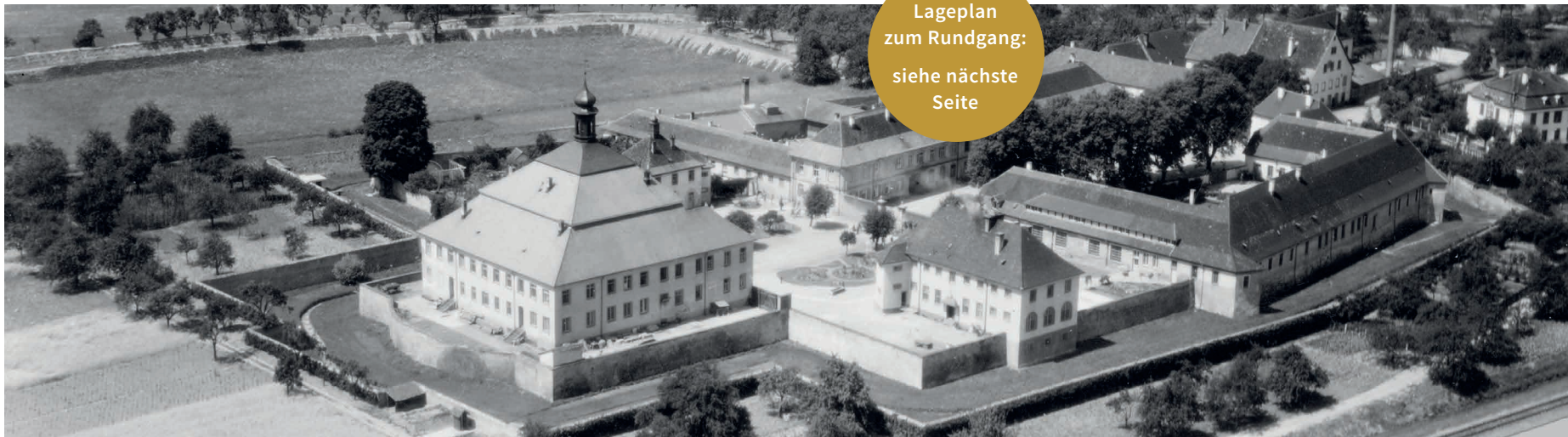
Abbildungen auf dem Titel und rechts: Schlossanlage Kislau, aufgenommen 1935 von Süden (Titel) und Südosten (rechts) [Strähle Luftbild, Schorndorf]
